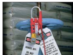
Sperrventile verriegeln
