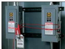
Einzelne oder mehrere Hauptschalter verriegeln
